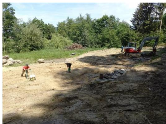
In der Mitte des Bildes ein weiterer Aushub in Arbeit. Die Auskleidung erfolgt mittels geeigneter Folien. Teile von Stein- und Asthaufen sind bereits vorbereitet.
